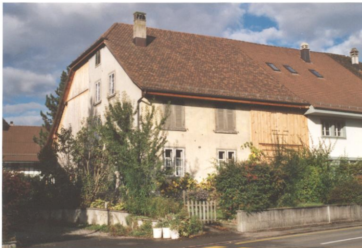
Das Ortsmuseum an der Riedenerstr. 75 vor den Umbauarbeiten.
